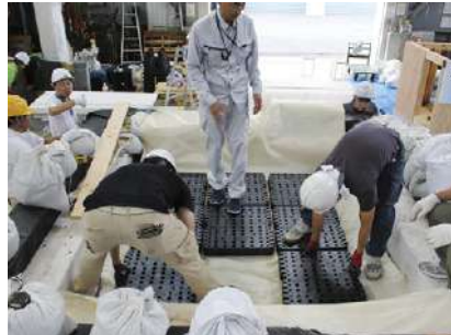
スーパージオ®SG70施工
