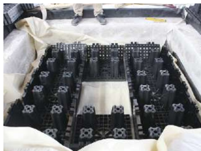
スーパージオ®SG300施工
